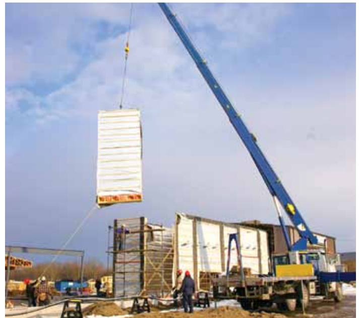
Installation de sections de murs préfabriqués
