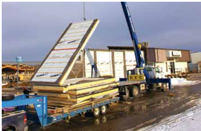
Section de murs préfabriqués de 5,5 m (18 pi) de hauteur
