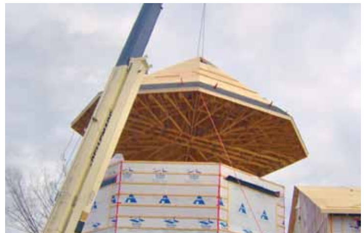
Installation de modules de fermes de toit pré-assemblés au sol
