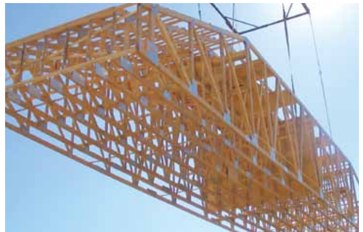
Fermes légères à connecteurs métalliques
