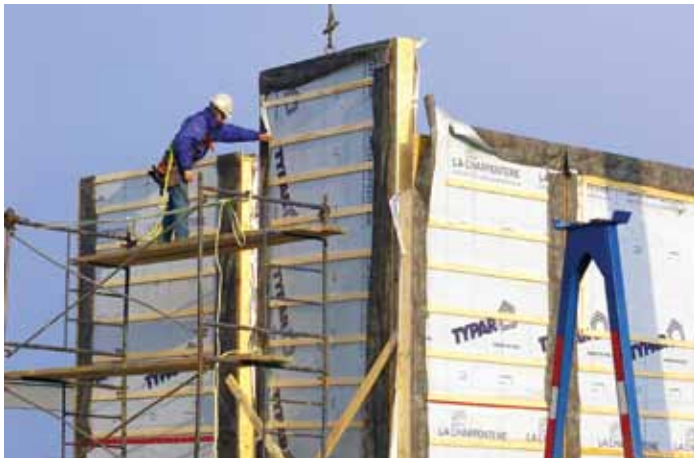
Installation de sections de murs préfabriqués
