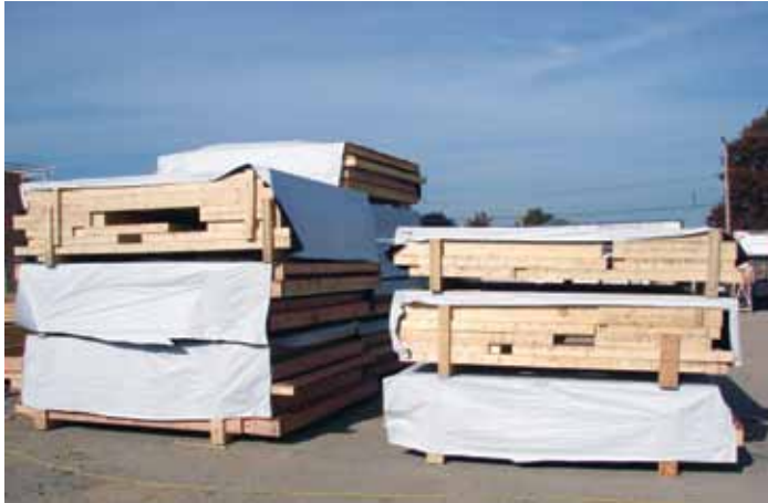
Entreposage adéquat au chantier de sections de murs préfabriqués
